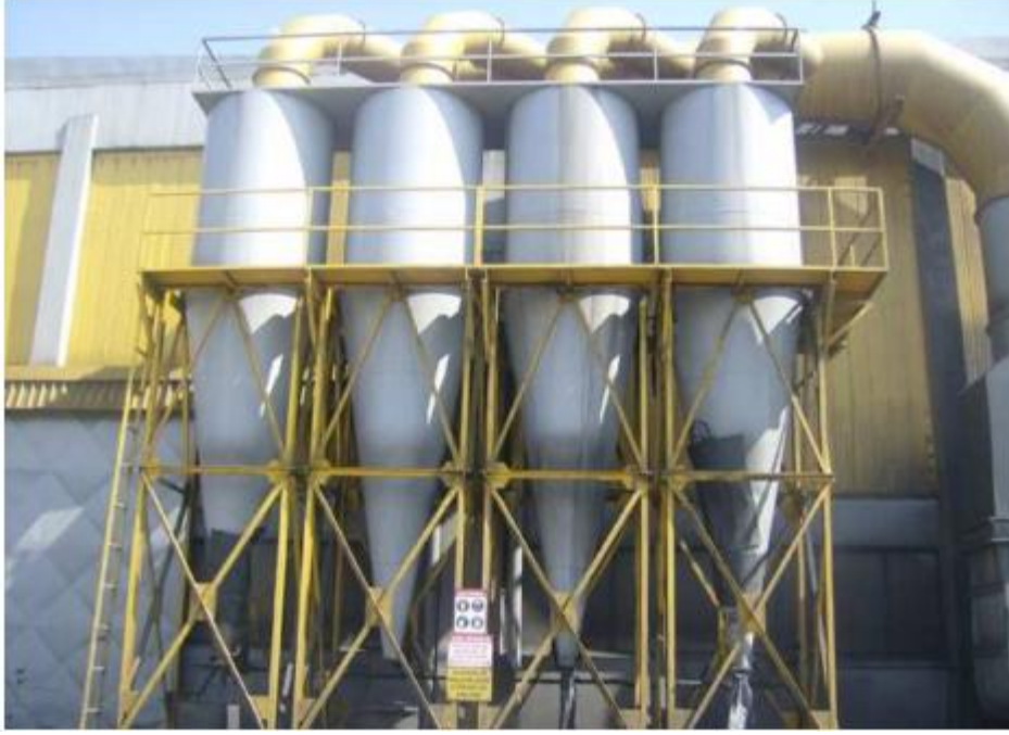
Şekil-6 Multisiklon Sistemi
