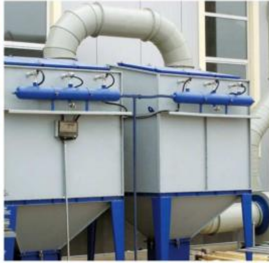
Şekil-12 Zımpara tozları, zımpara tezgâhlarına uygun özel aparatlar ile emilerek Patlaçlı Kartuş Filtre (Jet-Pulse) ile filtre edilerek ortama geri verilir.
