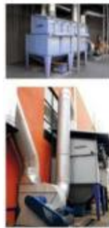
Şekil-12 Zımpara tozları, zımpara tezgâhlarına uygun özel aparatlar ile emilerek Patlaçlı Kartuş Filtre (Jet-Pulse) ile filtre edilerek ortama geri verilir.
