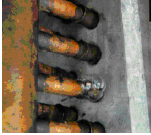
Şekil-10 Kondenser manifoldunun bağlantı noktasında kabarcık testi
