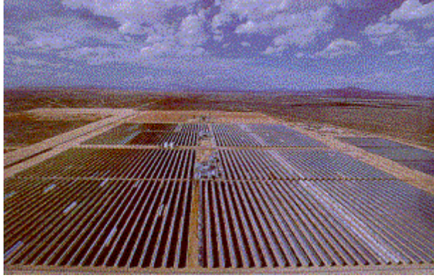
350 MW gücünde parabolik oluk güneş santrali-Kaliforniya
