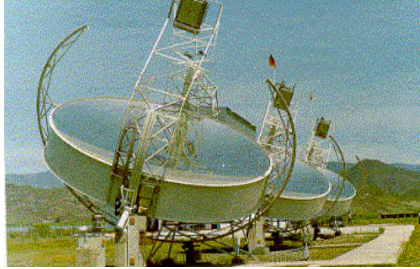
Parabolik Çanak Güneş Isıl Elektrik Santrali (İspanya)
