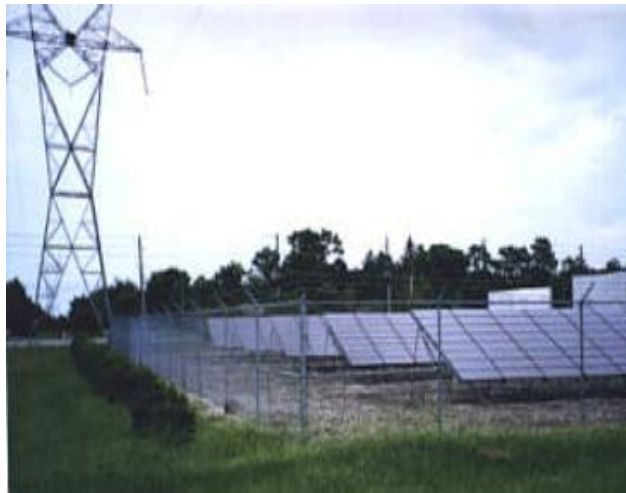
Şebekeye Elektrik Veren Güneş Pili (PV) Sistemi
