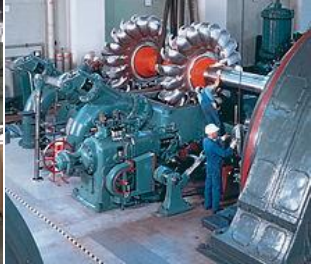
Şekil-4.9 Pelton türbini
