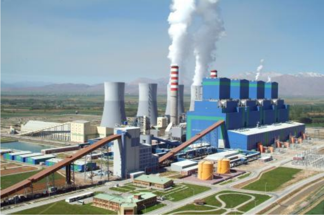
Şekil-2.5 Afşin-Elbistan termik santrali
