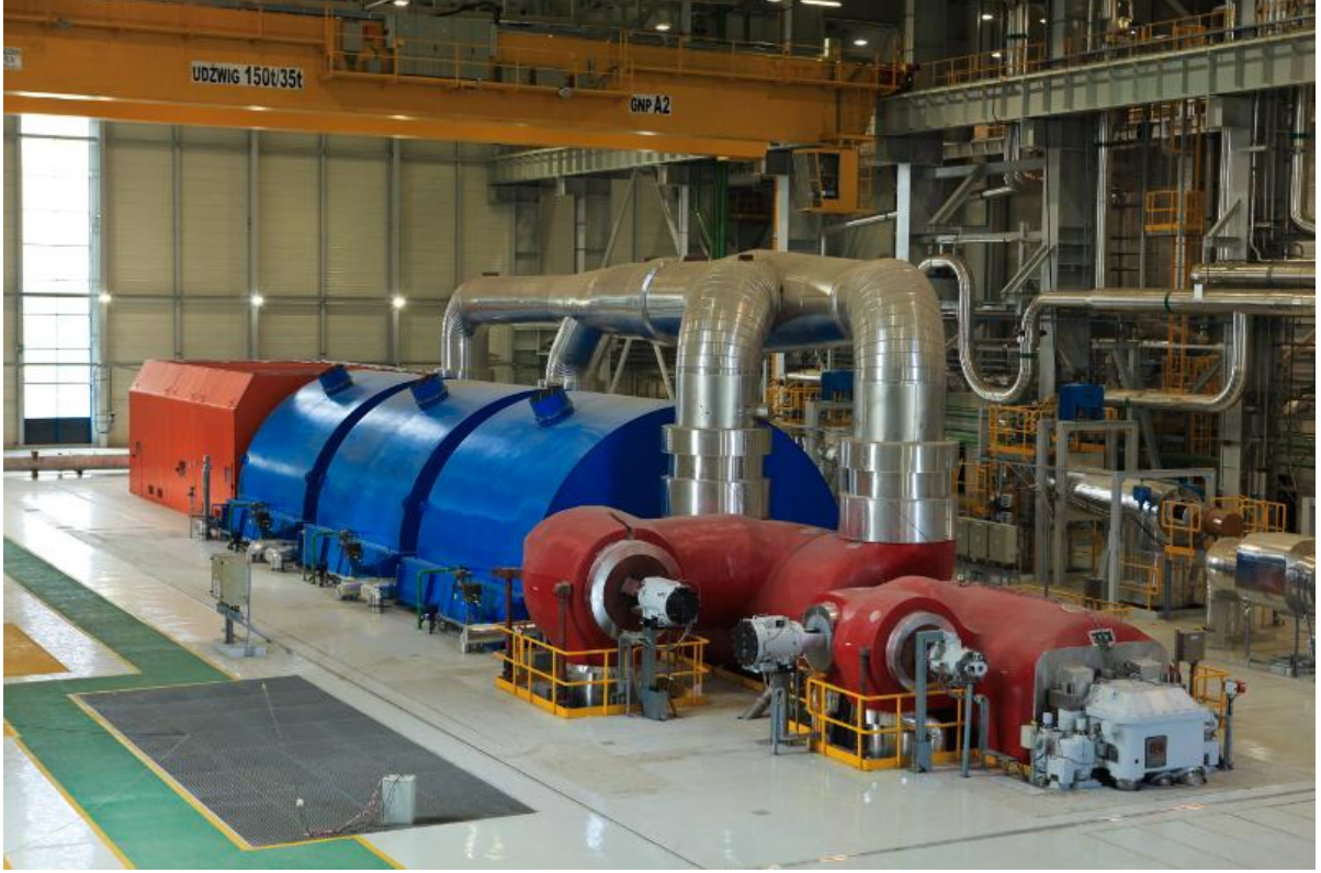
Şekil-2.14 Türbin-jeneratör sistemi
