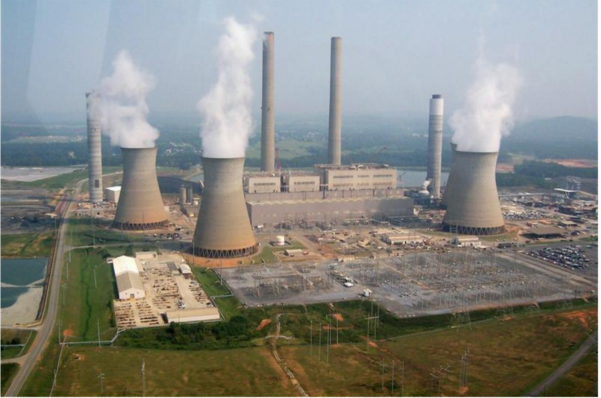
Şekil-2.15 Bir kömür santralinin soğutma kuleleri
